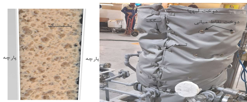
شکل ۱. پوشش آکوستیکی پتویی؛ (راست) نمونه ساخته و نصب شده، (چپ) برش مقطع پوشش.
